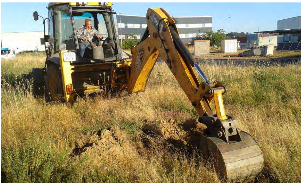
Labores de reconocimiento geotécnico en la parcela
